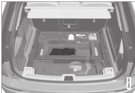
Starterio akumulatorius įrengtas bagažinėje.
