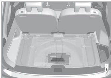
若車輛是配備 48V 支援電瓶，則位於行李廂下方。48V 支援電瓶上的盒子僅限由授權服務廠拆卸。
