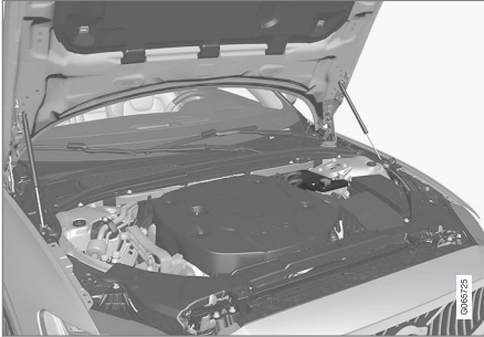
12 V atbalsta akumulators atrodas dzinēja nodalījumā.
